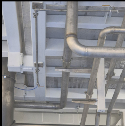
Instalasi Pipa CA SUS
