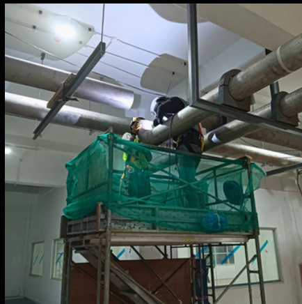
Instalasi Pipa Chiller SUS
