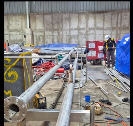
Instalasi Pipa CA SUS
