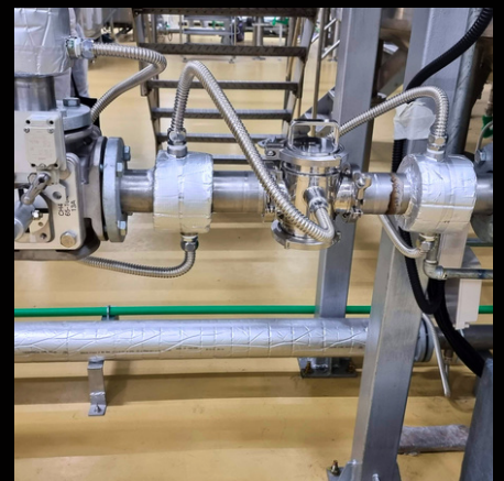
Instalasi Jacket Pipa SUS
